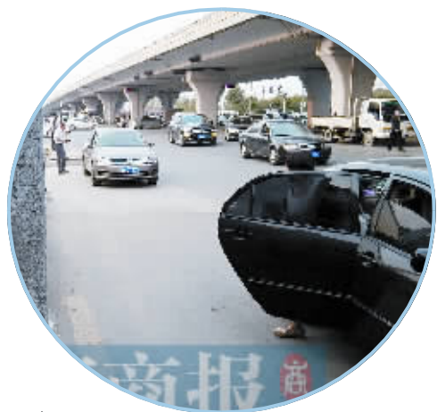
BRT通道上,私家车占道停车
