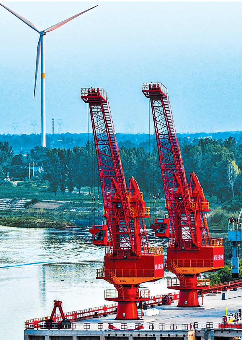
7月12日，夕阳下的郭滩枢纽尽显宏伟壮观的气势。作为南阳市唐河复航一期头号控制性工程，该工程将结束唐河断航数十年的历史，助力南阳成为水上开放口岸。 朱付新 摄
