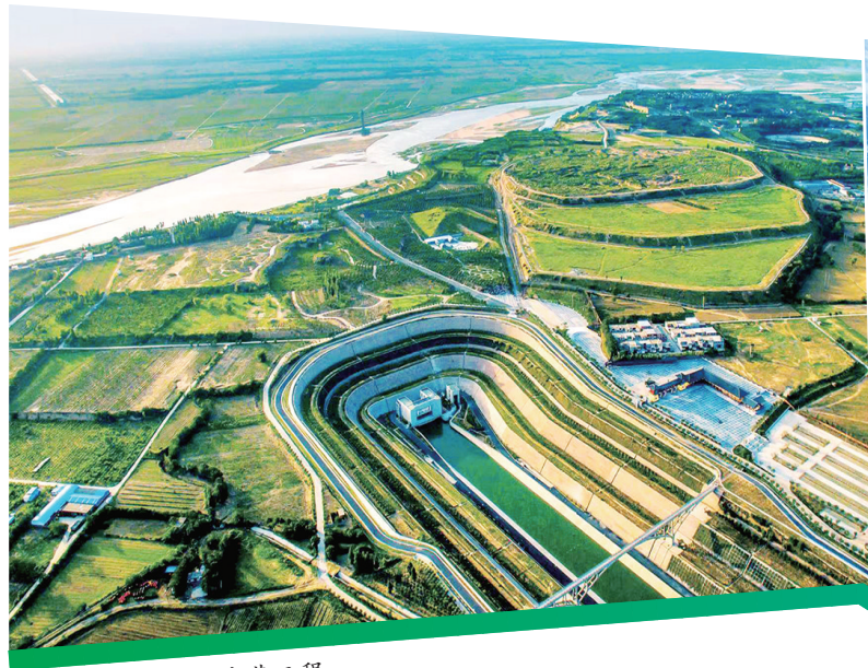
南水北调中线穿黄工程。
