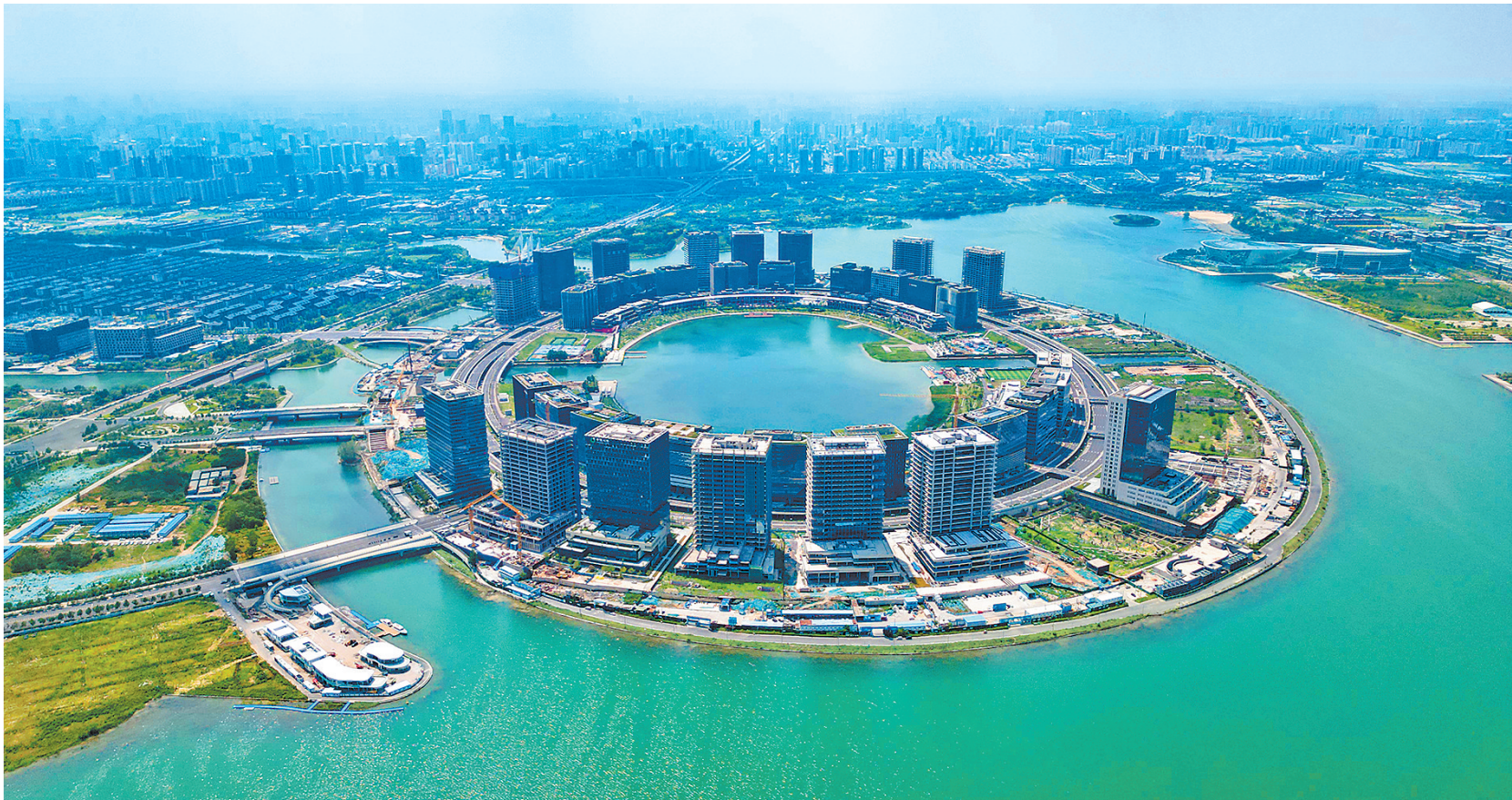
7月27日，郑州龙湖水城碧波荡漾，金融岛外环建筑正在紧张施工。 本报记者 聂冬晗 摄
