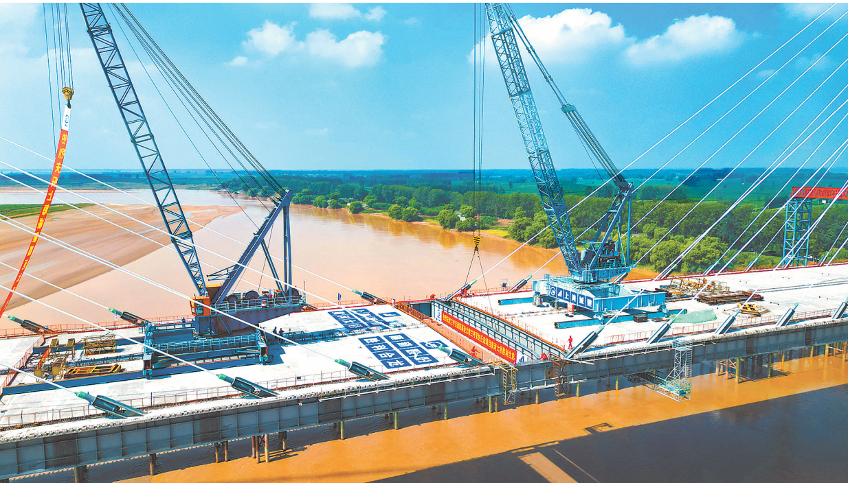
7月28日，兰原高速兰考至封丘段项目黄河特大桥主桥完成最后一根横梁吊装，提前实现合龙。本报记者 最冬晗 摄
