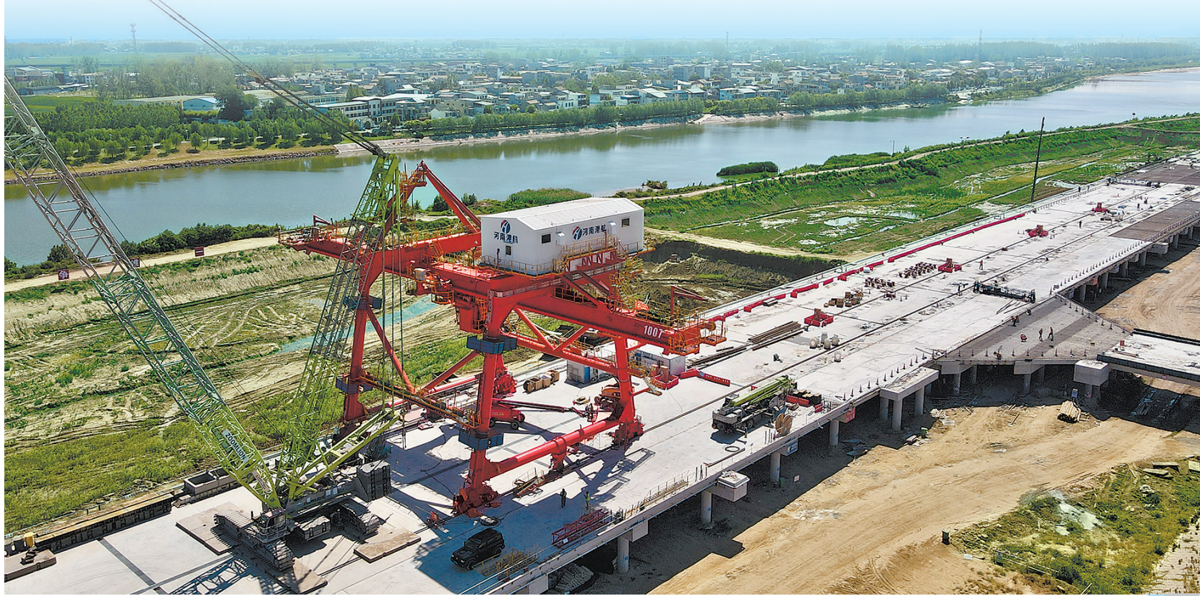
7月28日，在周口港中心港区中心作业区（一期）工程建设现场，自动化集装箱岸边起重机总装完成。 本报记者 王铮 摄
