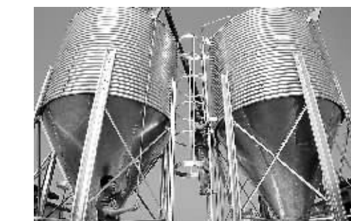
9月4日,社旗县李店镇王庄村肉鸡标准化养殖项目工地上,工人们正在安装自动化饲料喂生产线设备。湖北省神力集团投资1.2亿元在该村兴建了肉鸡标准化养殖基地,建成后年产肉鸡100万只。⑤2 张林 摄
