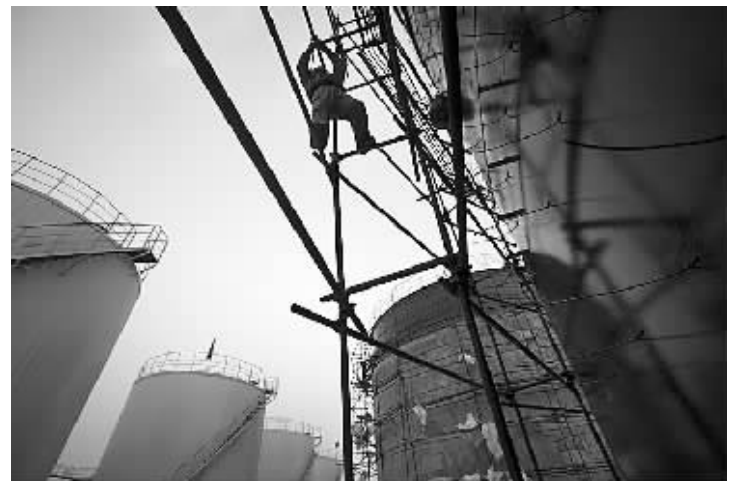
12月10日，位于濮阳工业园区的佳化能源新能源产业基地项目储罐主体已全面完工，施工工人正在进行防腐、试漏、防雷防静电和消防围堰施工。该项目总投资5.9亿元，建成投产后将安排就业岗位3000多个。③3
