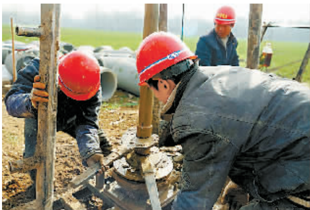
12月10日,项城市高寺镇抓住上冻之前的有利时机,开展高标准农田水利基本建设,完善“田成方、林成网、旱能浇、涝能排”的农业新格局。⑤3 赵献伟 摄
