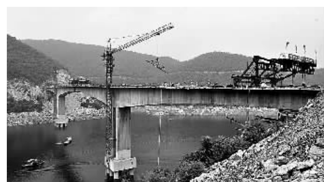
浙川县首座跨丹江口水库大桥——丹江小三峡大桥近日成功合龙,预计9月底建成通车。该桥位于浙川县马蹬镇八仙洞风景区,全长332米,桥面宽11米,主跨度达150米,是我省同类桥型中跨度最大的。⑤1 崔培林 阙爱民 摄
