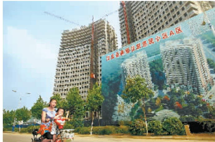
8月10日,沈丘县一名市民正在建设中的高层廉租房前经过。该县建设的廉租房惠民小区有两幢高23层的楼房,建筑面积达5万平方米,可安排1000户住房困难群众入住。⑤3 本报记者 王天定 摄
