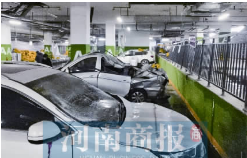
地下车库顶部热力管道脱落,有私家车被砸后严重变形 河南商报记者 张郁摄
