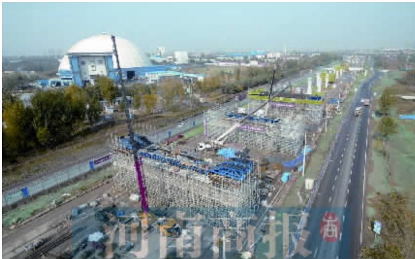
南四环高架建设工地，再过一段时间就可以架设预制梁
