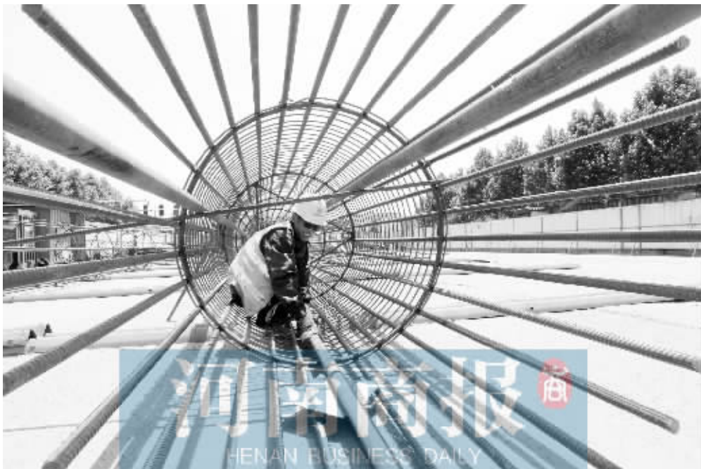
河南商报记者在现场看到,四环桩基正在紧张施工
