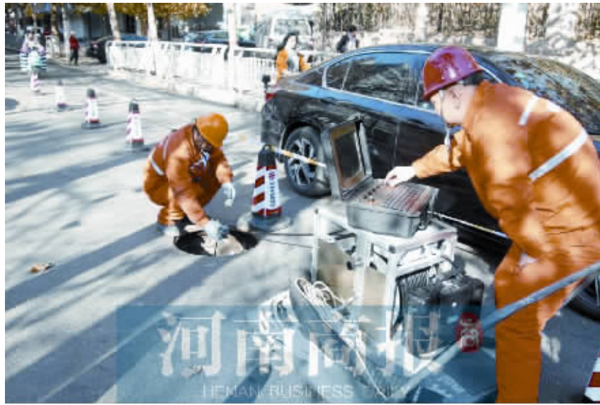
市政工作人员展示不挖路维修地下管线设备
