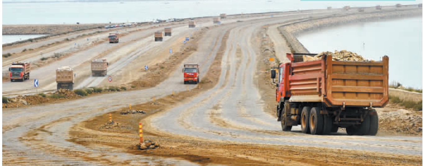
9月14日,大连新机场建设工地,运输土石方的重型卡车穿梭忙碌
