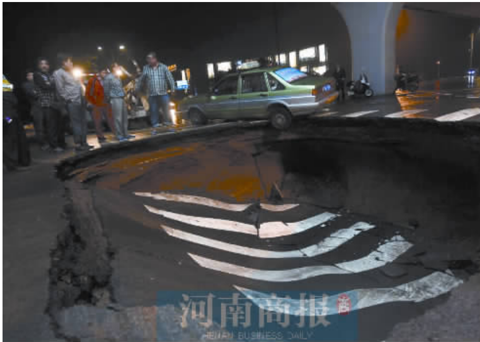
昨晚10点多,中原路西三环立交桥下再次发生塌陷
