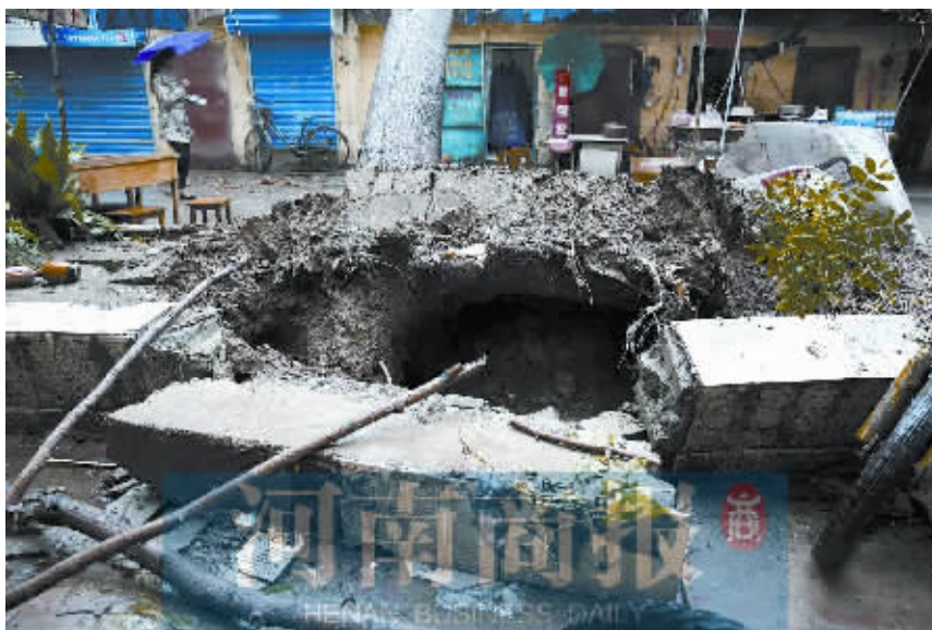
人民路14号院这棵倒下的泡桐,根部腐烂严重
