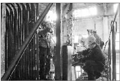
8月2日,中原油田供热管理处热六大队工人们在冒着高温酷暑对原有的锅炉燃烧系统和分离系统进行设备节能改造。目前油田供热系统的职工正利用夏季对锅炉进行节能改造。③3 胡庆明 摄
