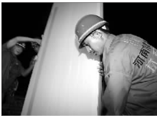
5 月 28 日 23 时,河南六建的施工工人们正在加班加点搭建活动板房。目前,他们所搭建的 54 间活动板房地基基本完成。③3 本报记者 董亮 摄
