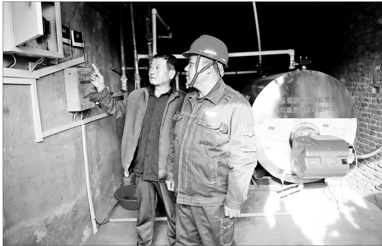
对电锅炉用电安全情况进行检查 郑亚亚 摄
