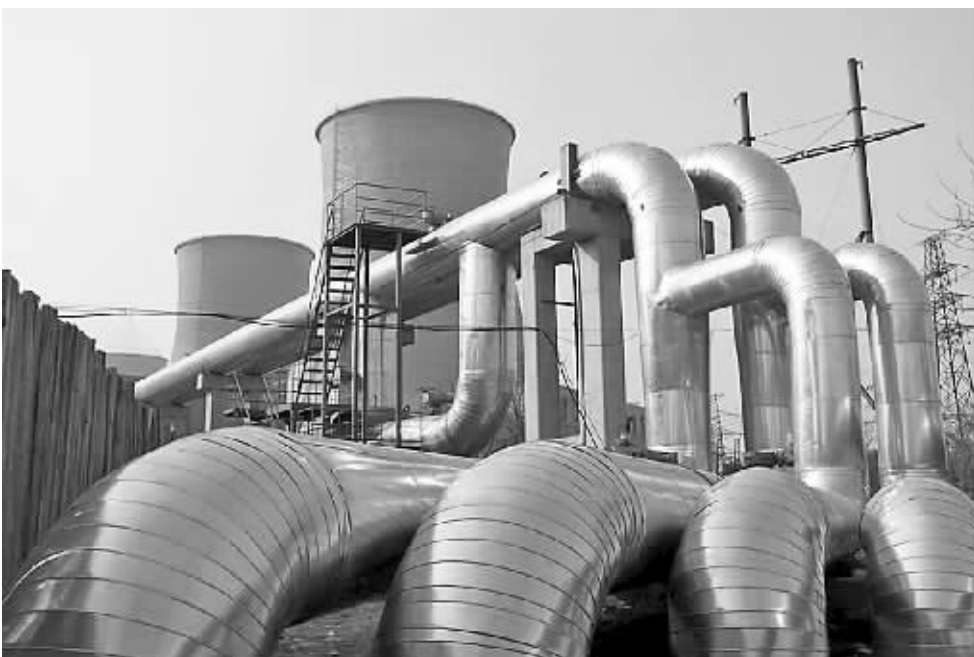
供热企业对主管网进行了换新改造
