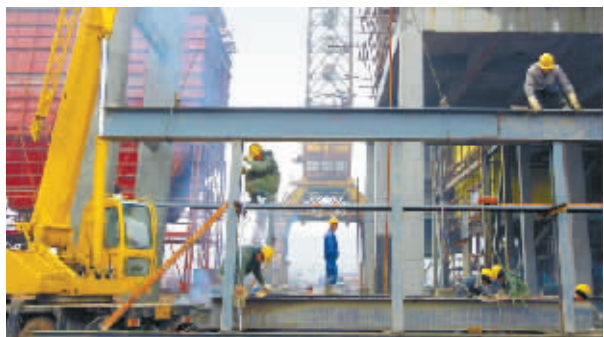
12月6日,义马煤业综能有限公司年产500万标方煤制气项目工程正在安装设备。该项目总投资30亿元,现已完成土建工程,设备安装全面铺开。⑤3 本报记者 王天定 摄
