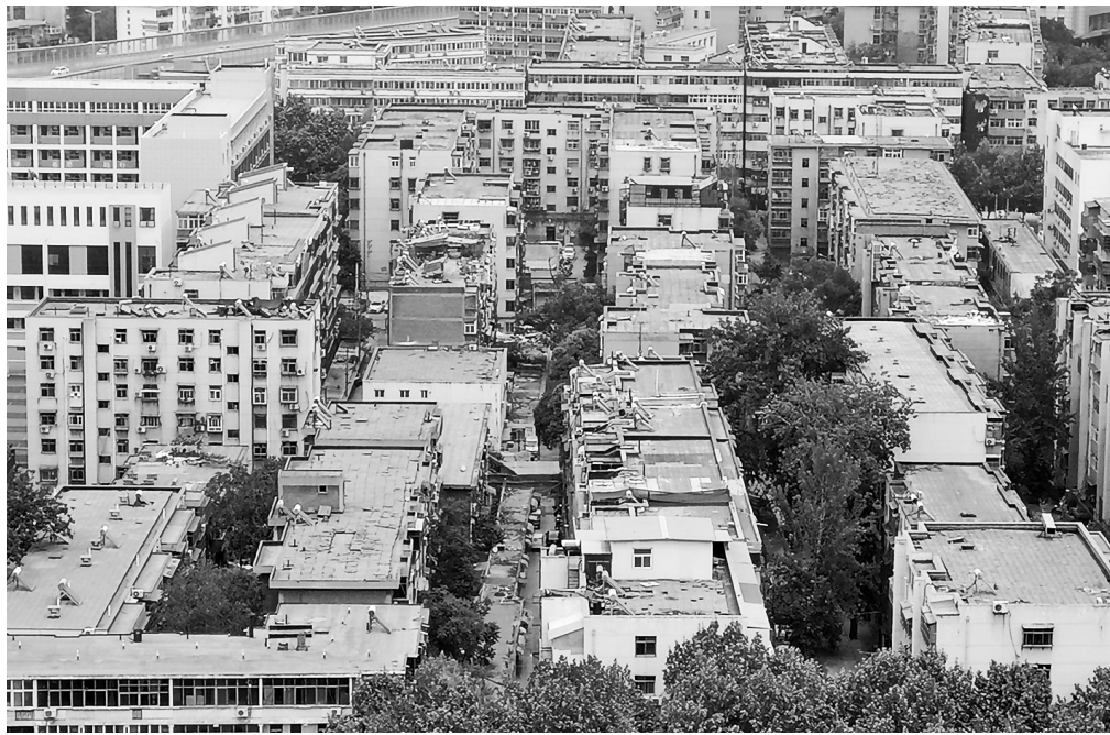
一老旧小区居民楼上建造的活动房
