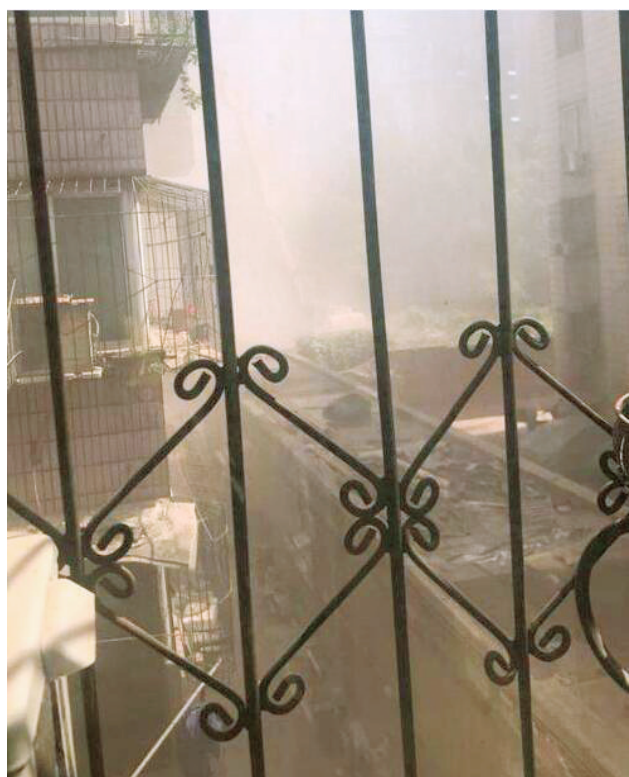
居民家中拍的拆迁现场
