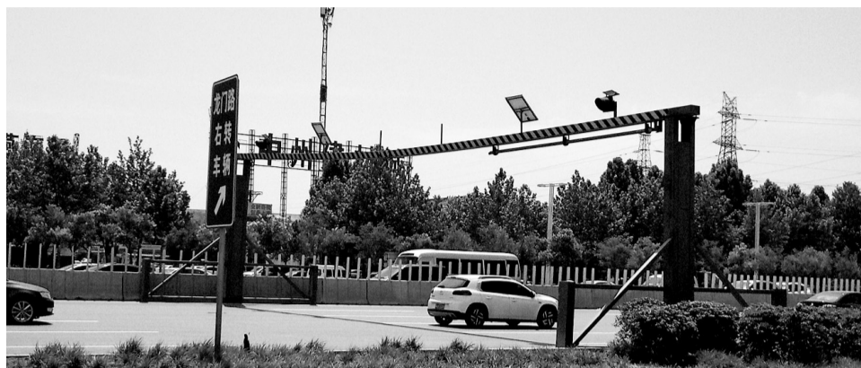
完成维修的限高杆上面暂时还没有限高的提醒标志
