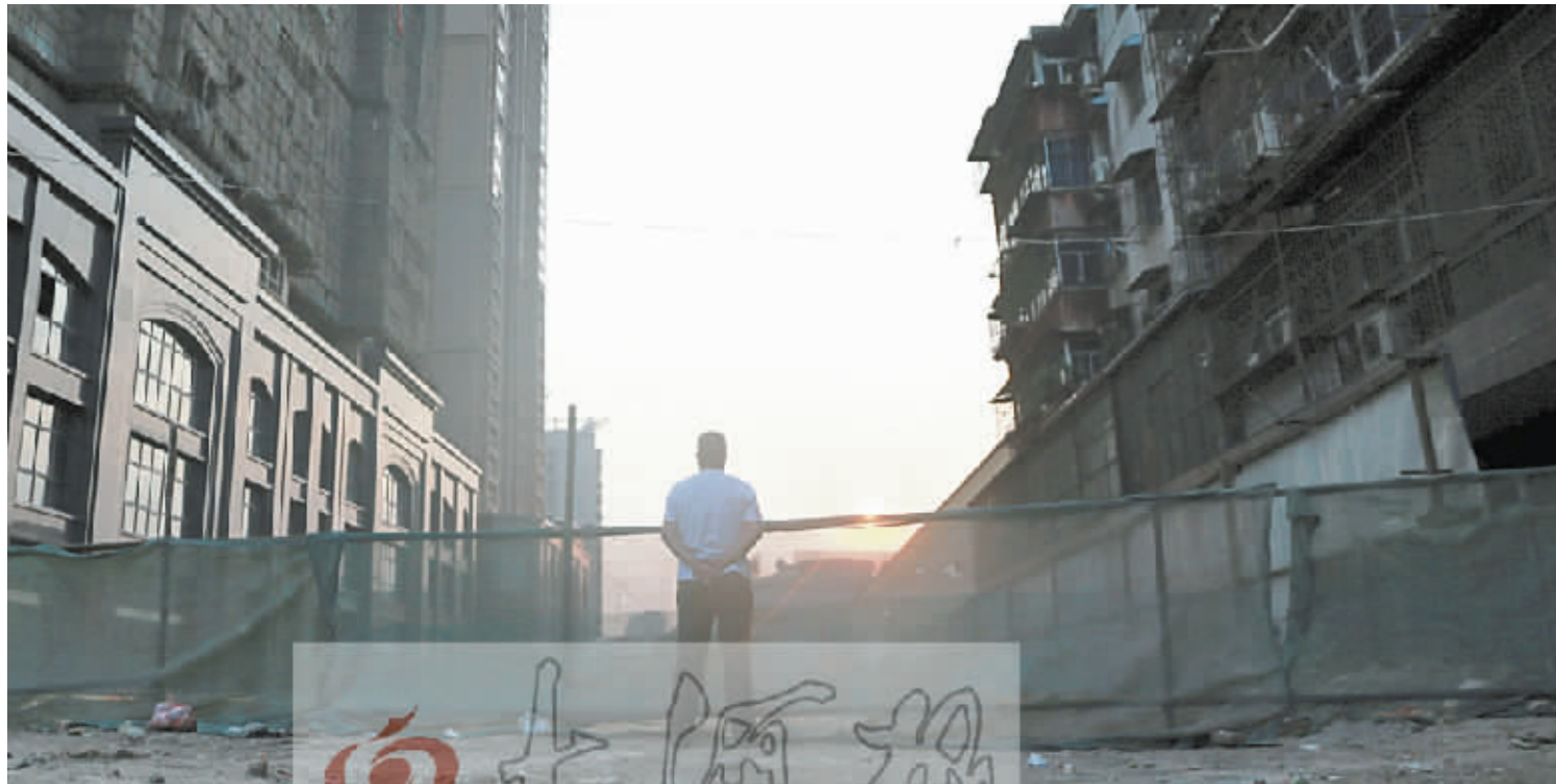
建设中的写字楼
