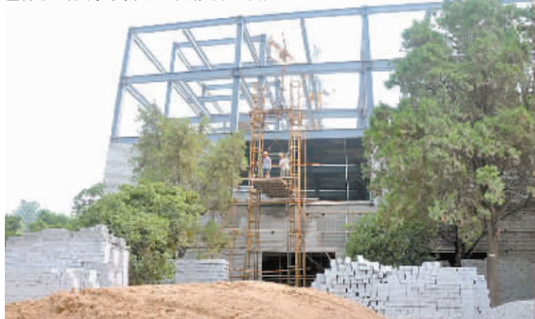
汴京公园海洋馆施工现场
