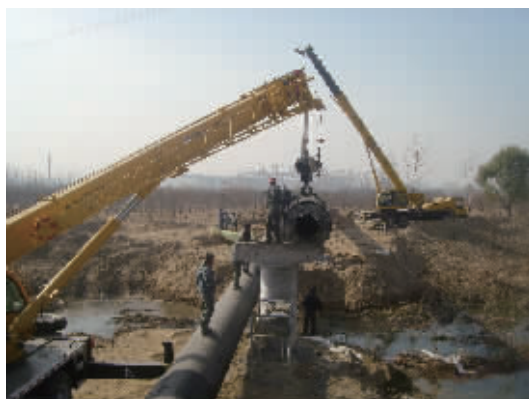
铺设热力管道
