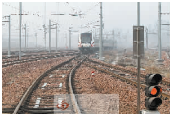
试运行的地铁列车开出库准备“入地”
