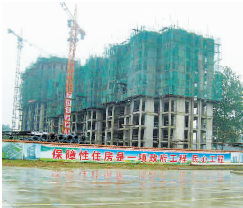
在建的惠民小区
